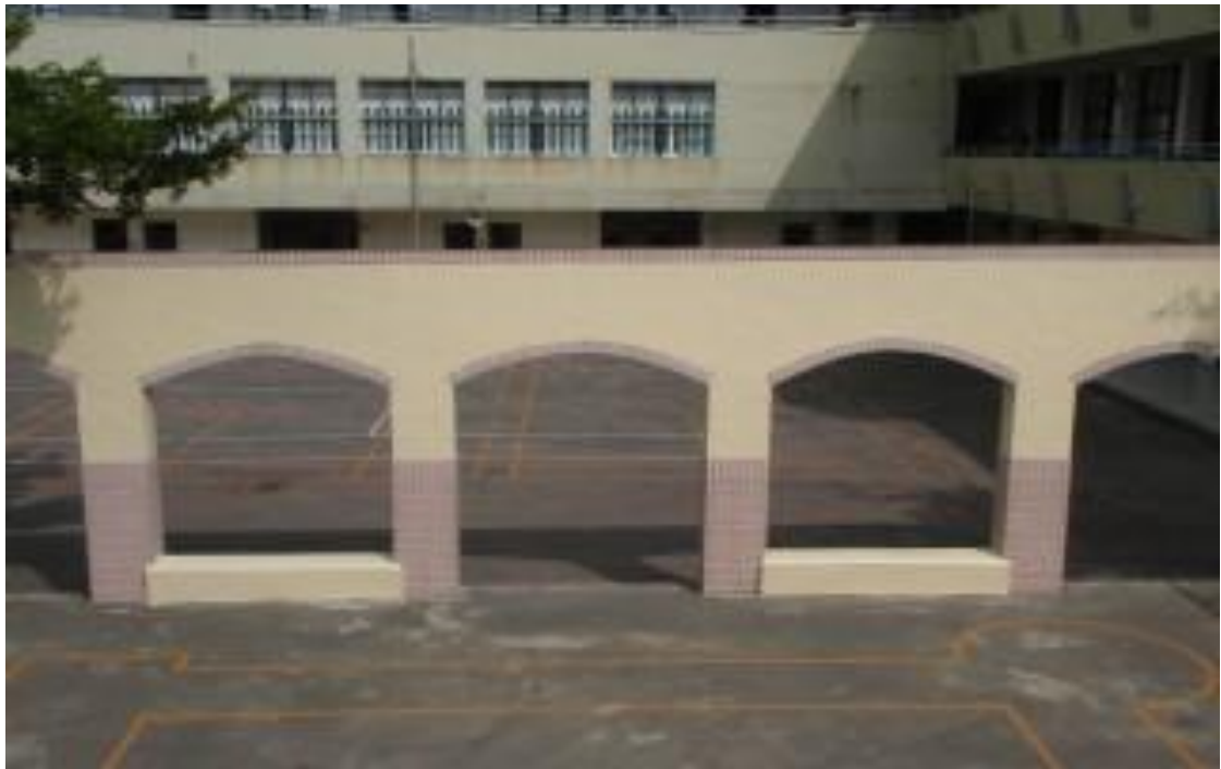
石門國小交通安全學習區---施工前
