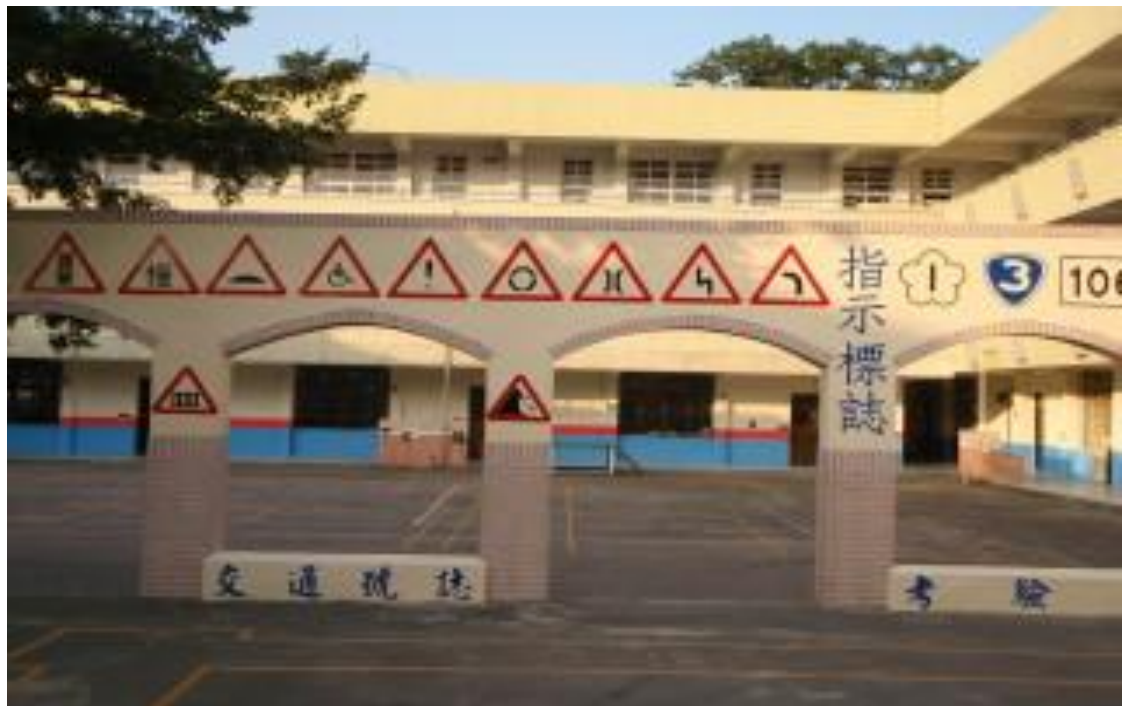
石門國小交通安全學習區---施工後南面
