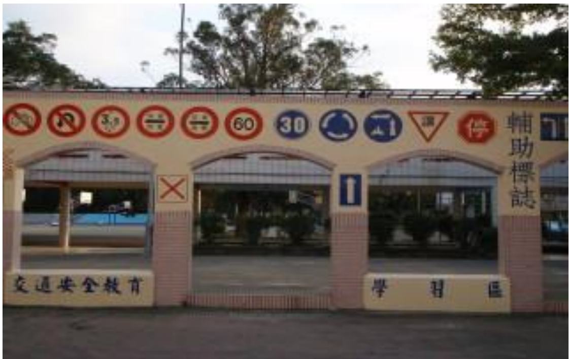
石門國小交通安全學習區---施工後北面
